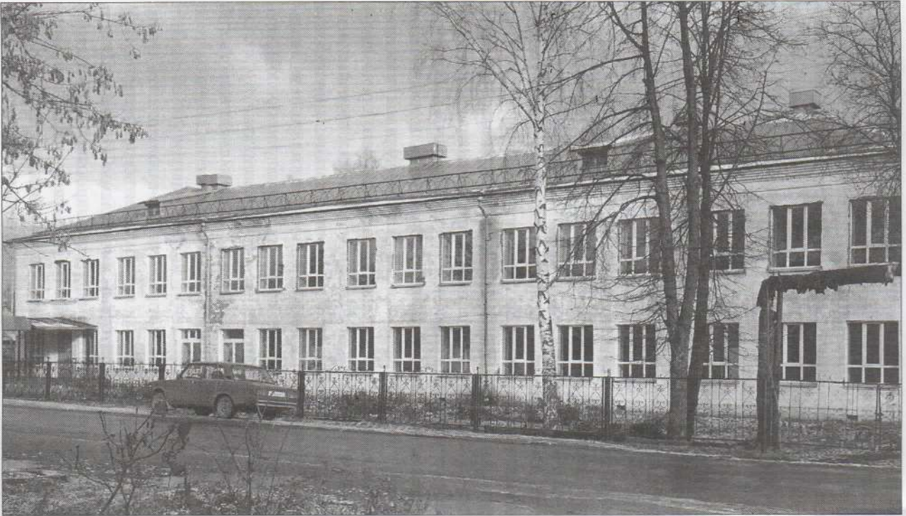
Здание на улице Школьной в посёлке Мурыгино, где располагалась средняя школа (современный снимок)
